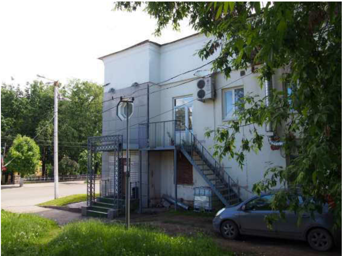
Фото 10. Боковой (северный) фасад. Фрагмент. Вид с северо-запада.
