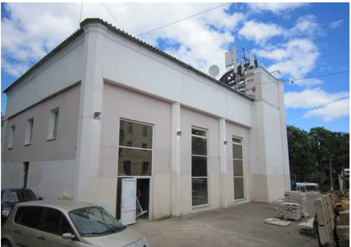
Фото 6. Фасад по улице Молодой Гвардии (южный фасад).
