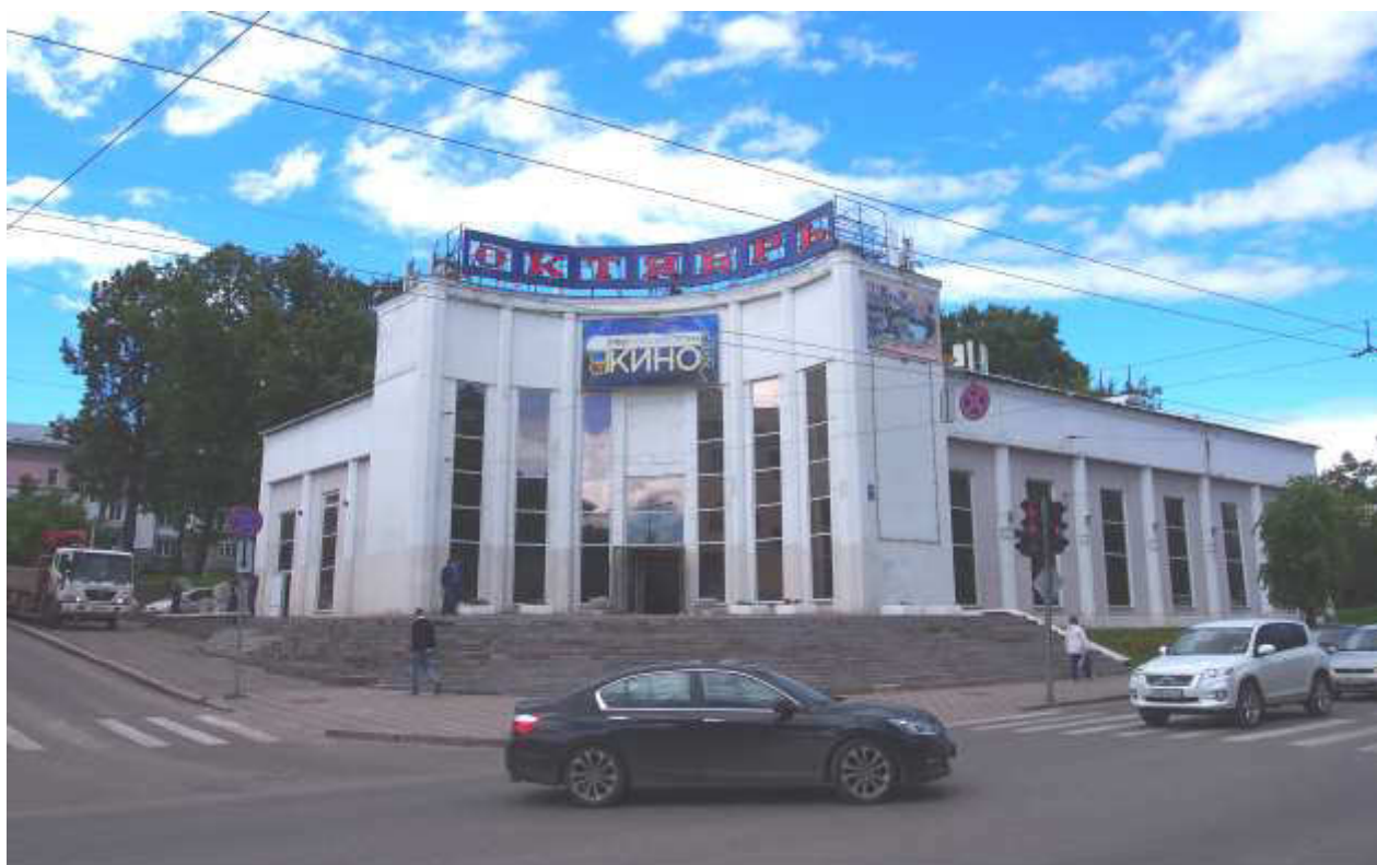
Фото 1. Общий вид с перекрестка улиц Карла Маркса и Молодой Гвардии. Вид с юго-востока.
