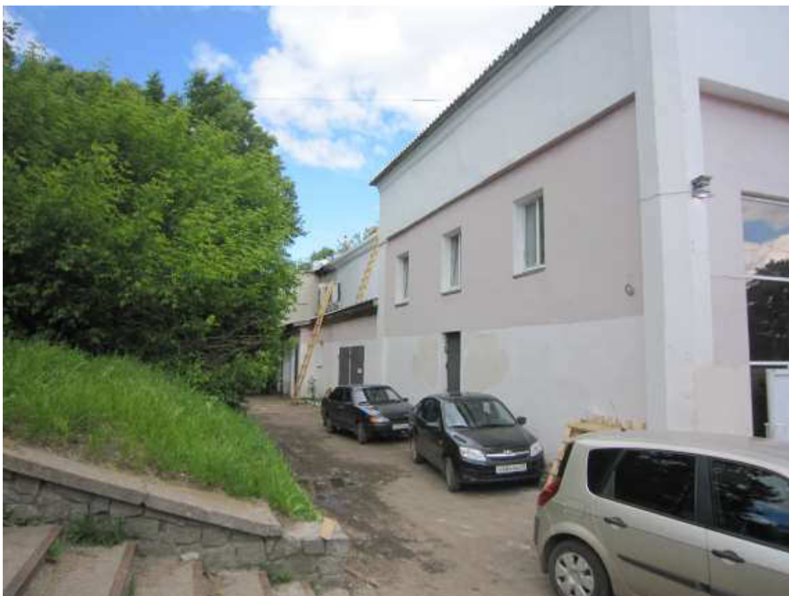
Фото 7. Дворовой (западный) фасад. Вид с юго-запада.
