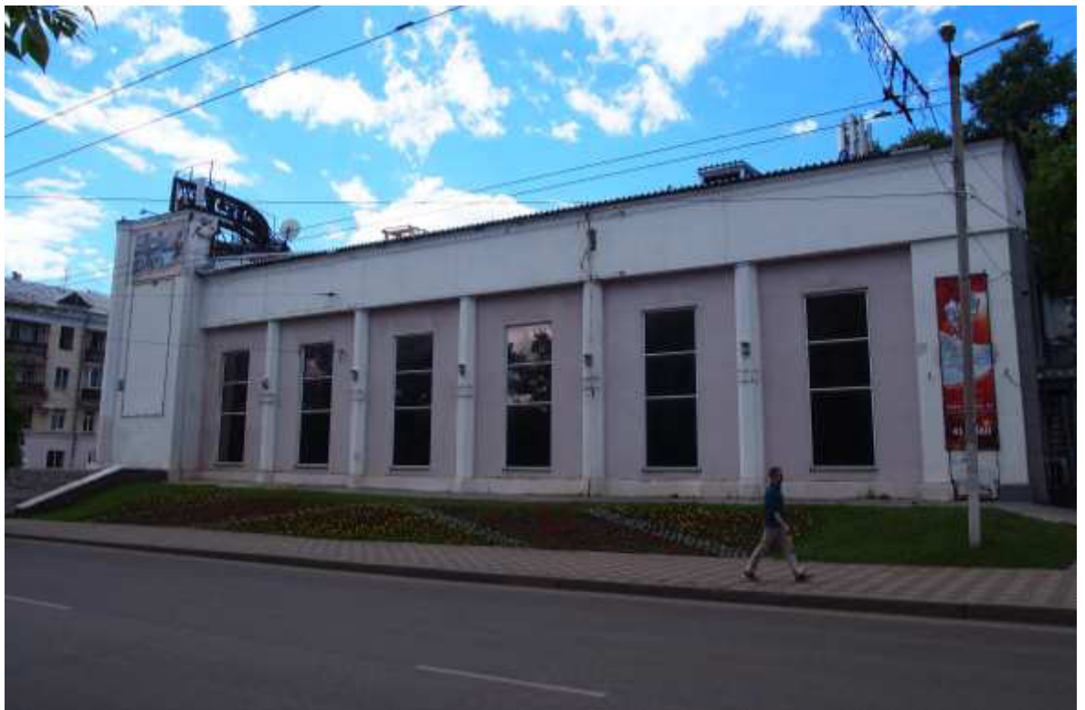
Фото 4. Фасад по улице Карла Маркса (восточный фасад).
